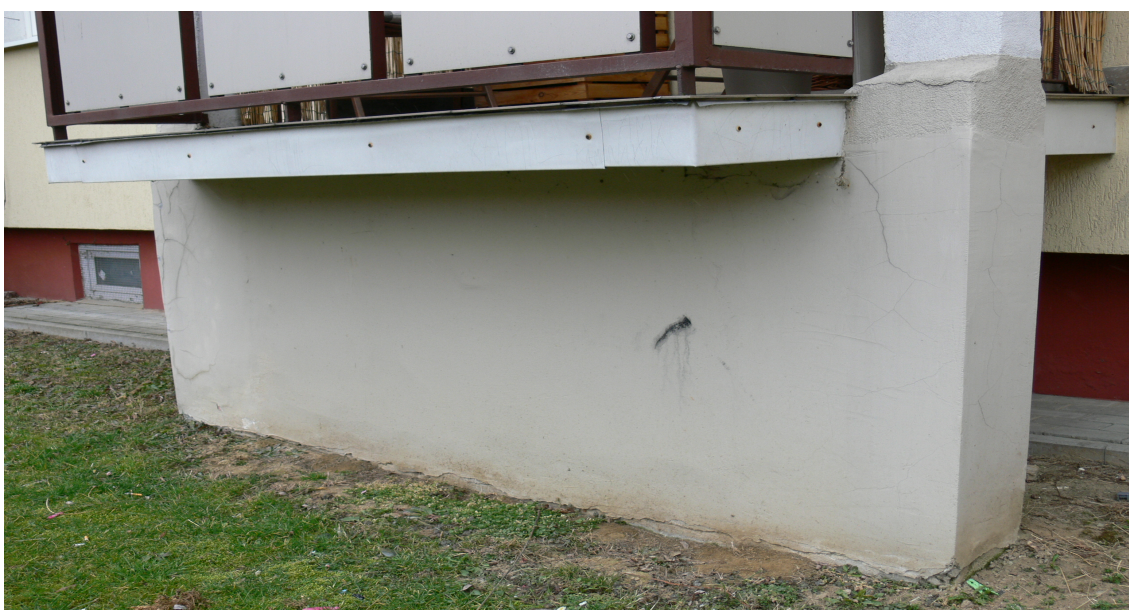
Fot 2. – Sciana żelbetowa na której posadowiono ramy żelbetowe
